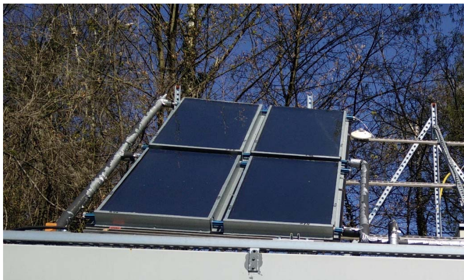
Abbildung 52: Kollektorfeld (um 5° gegenüber der Horizontalen geneigt)
