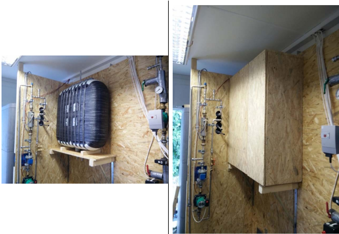
Abbildung 54: Drain-Back-Gefäß (Links: ohne Isolierung / Verschalung. Rechts: mit kompletter Einhausung)
