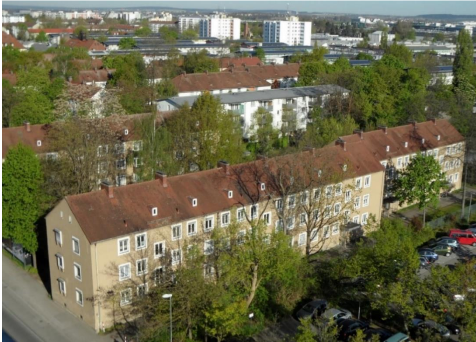
Abbildung 1: Aufnahme des Viertels Richtung Nordwest mit älteren Gebäuden (Ziegeldach) und neueren Gebäuden (Blechfalzdach)
